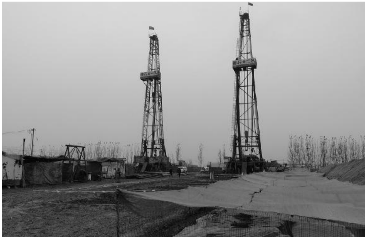
近日,由第一勘探局邢台光华监理公司承揽的山东省邢泰煤业有限公司顶底板双重层灰岩威胁煤层水害治理项目开工,预计工期500天。图为施工现场。 臧春业 焦文斌 摄影报道
