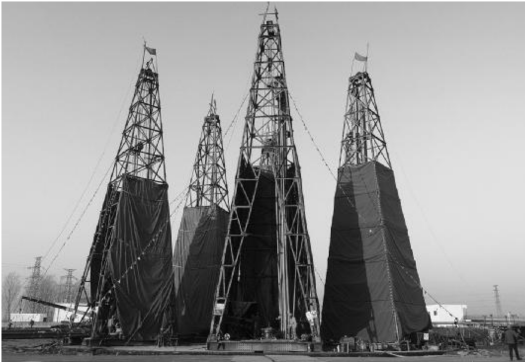
近日，安徽省煤田地质局三队承揽的赵园一矿西进风井井筒冻结钻孔工程开工。该工程设计钻孔107个，总工程量52906.5米，合同工期105天，投入钻机6台。图为井场钻塔群。 郝卫光 闻家俊 摄影报道
