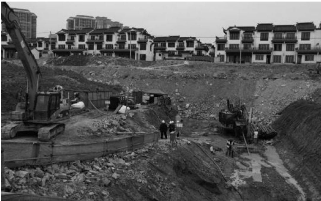
近日,由贵州省煤田地质局一四二队西能能达穿越公司负责实施的花溪湖水系专项工程退水管定向钻孔工程开工。该工程是一四二队承接的穿越长度最长的定向钻孔工程,项目全长约1.9千米,铺设管道为管径1000毫米的PE管,主要目的是通过管道退水,使花溪湖水保持清洁,进而保护湖内生态环境。项目将分5段进行施工作业。李红涛 摄影报道
