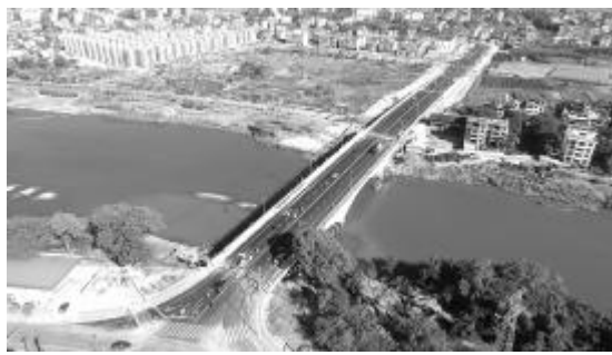
兴国县交通提升PPP项目凤凰大桥工程
