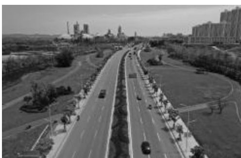
信丰县迎宾大道综合改造工程
