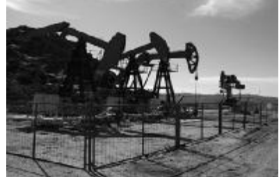
阜康白杨河区块煤层气开发利用先导性示范工程
