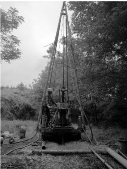
近日，陕西省一三一煤田地质有限公司钻井工程一公司承揽的中卫至平凉铁路扩能改造工程地质勘查项目顺利竣工。该项目共施工钻孔250个，钻进尺9667米。
