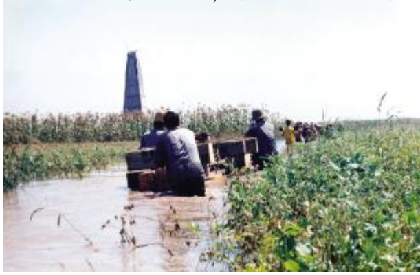
1990年8月25日，安装工人向钻机运送地梁木
