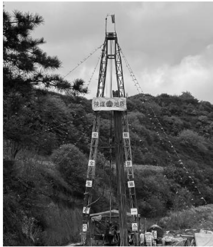
4月29日，由陕西省一八六煤田地质有限公司煤田勘探工程处2001钻机负责施工的崔木煤矿23盘区补勘B33-4号孔顺利开钻。该孔为探煤孔，设计孔深650米，旨在了解崔木煤矿采煤区边界情况，要求煤样准确，对水位观测情况进行详细记录。 肖圣泽 摄影报道
