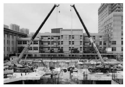
煤长江基础建设 有限公司常州分 公司负责施工的 常州市第二人民 医院阳湖院区二 期建设项目基坑 支护工程第一道 支撑拆除工作完 成。该项目建成 后可新增床位 1000 余张,将有 效解决当地医疗 资源不足的难 题
