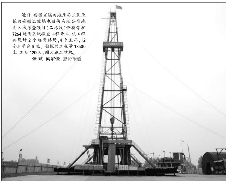
近日,安徽省煤田地质局三队承揽的安徽恒源煤电股份有限公司地面区域探查项目(二标段)任楼煤矿7264地面区域探查工程开工。该工程共设计2个地面钻场,4个主孔,12个水平分支孔,钻探总工程量13500米,工期120天。图为施工钻机。
