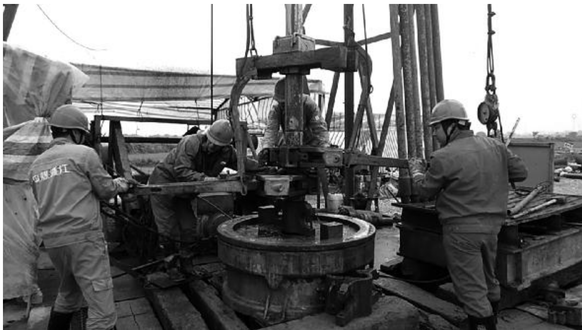
5月23日，由中煤浙江地质集团有限公司杭州分公司承担的江西ZK110号矿井高质量完井，实现了地下垂深1000多米处的“穿针引线”，成功与ZK109号矿井精准对接。 申建柱 摄影报道
