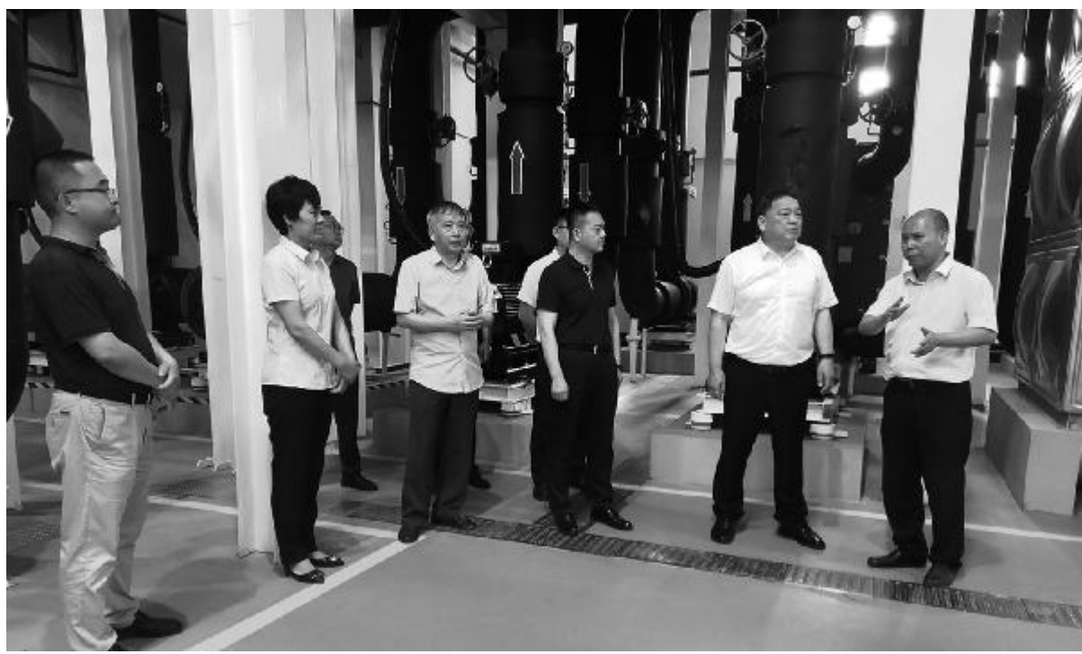
6月15日，第二勘探局局长刘勤学、总工程师陈洪一行到陕西中煤新能源有限公司眉县项目检查指导工作。陕西中煤新能源公司党总支书记张天安、总经理李兵等人陪同。刘勤学表示，新能源公司已经立足陕西，走到省外，更应该放眼全国，面向京津冀、长三角等地区，为我国碳达峰、碳中和目标继续贡献力量。会后，刘勤学一行实地参观了G102地热井和一号能源站。
