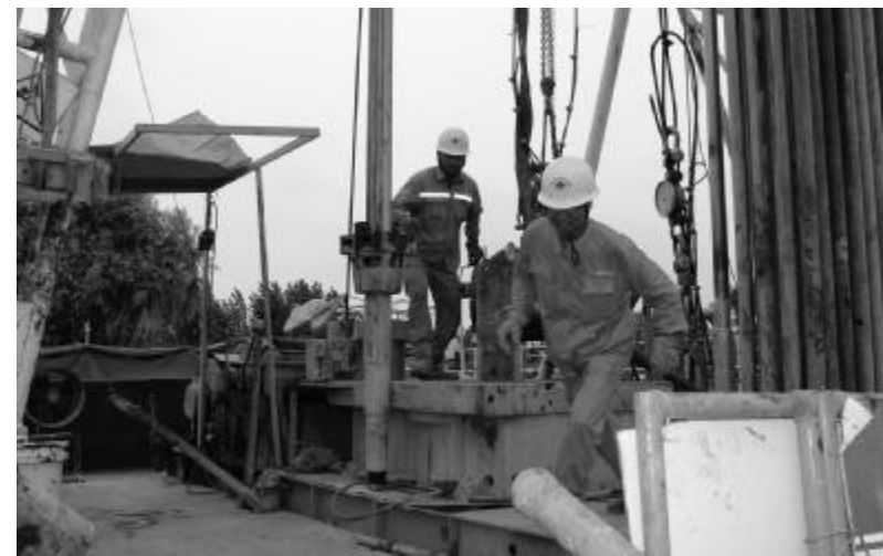
近日，山东省煤田地质局一队在济宁沉陷区治理项目钻机施工现场，开展了“实战”背景下的野外钻机异常气象疏散逃生应急演练。演练分为演练动员、险情报告、险情判断、启动预案、命令下达、紧急疏散、快速集结、清点人数、现场恢复等9个场景。 高峰 摄影报道
