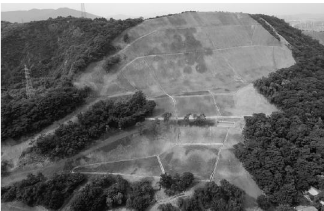
7月14日,由水文地质局三队承建的青龙山废弃露天矿山修复项目四标段,通过了由江苏省自然资源厅组织的省级验收,被评为优良工程。该项目完成主要工作量:削坡减载139485.5立方米;宕底回填及压脚45674.8立方米;土石方转运80639.9立方米;坡脚、平台、纵向排水沟、场地排水沟1844.5米;地形平整、整理20238.5平方米;回填平整13170.8平方米;挡土墙135.8米;蓄水池1座;挂网客土喷播29990.4平方米;普通喷播14261.6平方米;浇灌养护系统修建44252平方米;撒播草种12782.2平方米。 裴文斌 摄影报道
