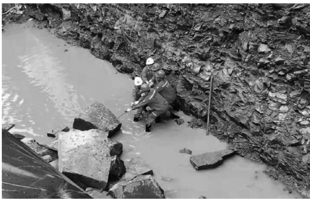
河南省资源环境调查二院工程一分院2018钻井队承担的美中能源有限公司煤层气钻井工程，井场表层石头多，渗漏严重，直接影响了生产正常开展。8月9日，职工们采取清除石头、破碎石块、铺垫防渗透布的方法，既有效防止了钻井液污染，又保证了工程如期开工。
