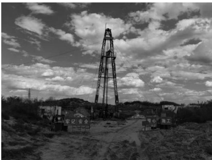
日前，由陕西省一八五煤田地质有限公司地质环境工程勘察院负责施工的小保当一号煤矿石拉岭进回风立井井筒检查孔工程开工。该项目位于神木市小保当，共设计钻孔2个，总钻探工程量为1030米。该工程将通过水文地质钻探、采样测试等手段查明井筒穿越各层地层结构、岩性特征，采用抽水试验获取各主要含水层水文地质参数，利用冻结样采样测试获取井筒冻结段岩石物理力学特征，最终为井筒设计、施工提供可靠的地质依据。
