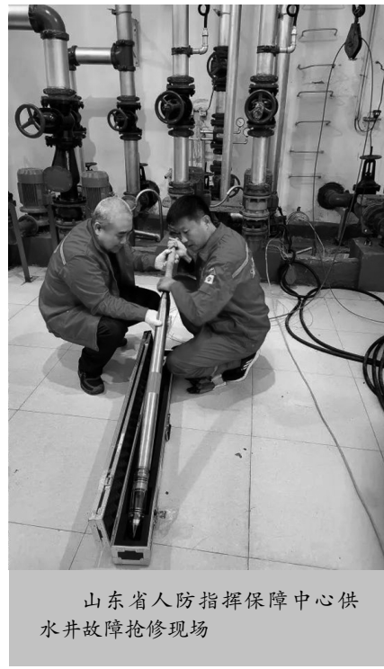
山东省人防指挥保障中心供水井故障抢修现场
