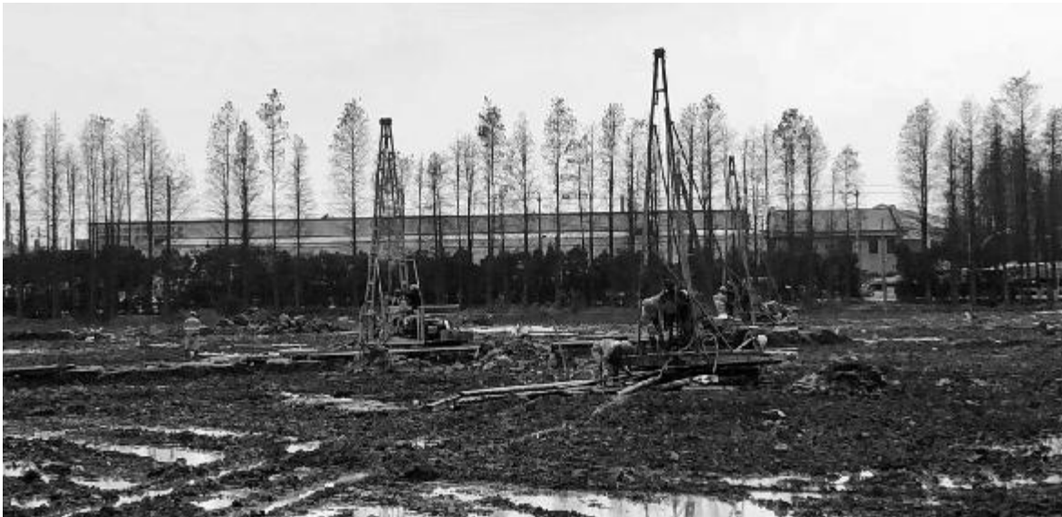
近日，中煤浙江勘测设计有限公司宁波分公司克服工期紧、人手少等困难，快速完成了镇海一期光罩厂项目的勘察任务。该项目是宁波市镇海区引进的高科技项目，对发展地方经济有重要作用。中煤浙江勘测设计宁波分公司接到任务后，迅速抽调人员组成8个机台进场施工，提前完成了勘察任务。
