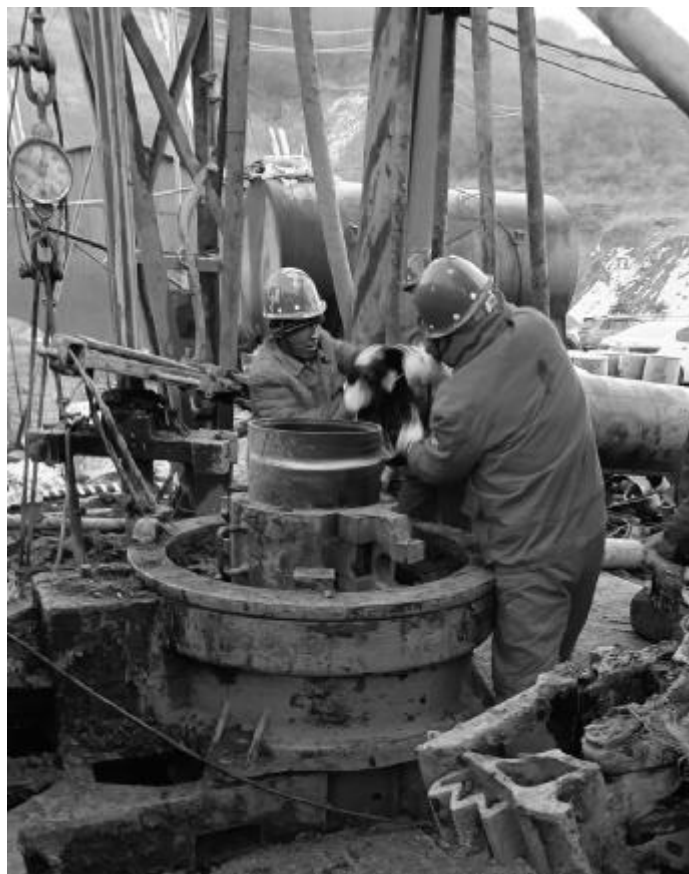
近日,陕西省一八六煤田地质有限公司崔木煤矿北翼风井投料孔工程投料管下入及固井工作顺利完成。该投料孔设计孔深400米,将为崔木煤矿北翼风井井下掘进输送所需水泥、砂石等材料。 时超 摄影报道
