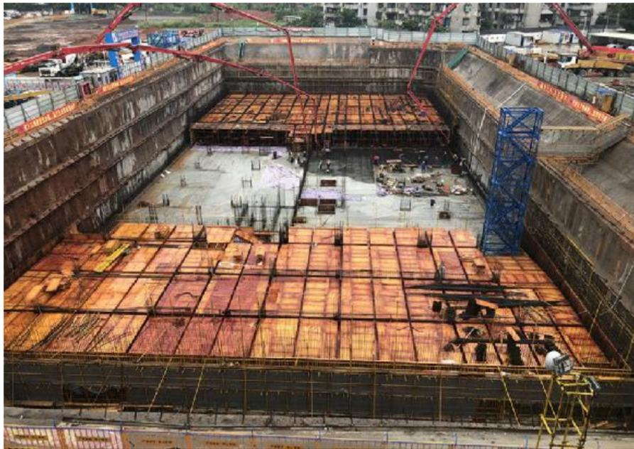
3月24日17时43分,中国煤炭地质总局粤港澳大湾区总部办公楼项目最后一块底板浇筑完成,浇筑混凝土3000多立方米,提前完成施工任务。项目位于广东煤炭地质局嘉禾大院内,占地面积1.14万平方米,规划高度99米,地上23层,地下3层,总建筑面积48228.89平方米,建设总投资约3.5亿元。
