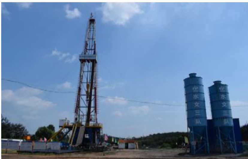
水文局三队羊东矿8470工作面区域治理工程注6孔工程
