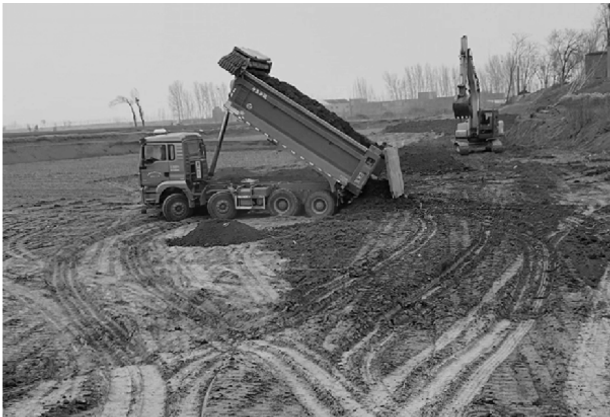
每晚召开生产调度会、多次优化技术方案、昼夜奋战施工一线……连日来，“抢工期”成为中能化发展建设集团有限公司淇县灾后重建项目部的关键词。作为河南淇县灾后重建项目的重点工程，10万亩高标准农田建设项目目前正在全面推进施工进度，全力备战即将到来的汛期，力保在汛前筑牢防洪防涝的坚实基础。 李玉广 摄影报道
