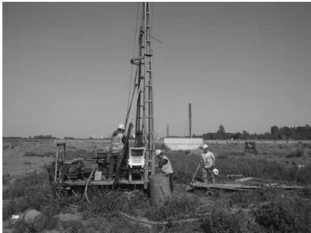
目前，山东省煤田地质局三队城市勘测事业部承建的泰安至东平高速公路桩基勘察项目正在紧张施工。该项目前期共设计施工孔位四百多个，钻探工作量约一万五千米。该队已完成钻孔一百一十八个，累计工作量三千米。 王惠梅 摄影报道
