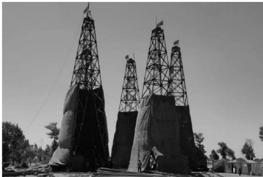
近日,安徽省煤田地质局三队承揽的内蒙古陶忽图煤矿主井井筒冻结造孔项目顺利开工。项目设计钻孔81个,总工程量37071米,其中主排冻结孔42个,防片帮孔36个,冻结孔工程量为34914米;另布置3个测温孔和1个水文孔,工程量为2157米,合同工期120天,投入钻机5台。
