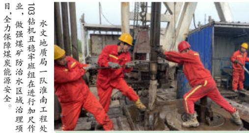
水文地质局一队淮南工程处033钻机班班组在进行加尺作业，做强煤矿防治水区域治理项目，全力保障煤炭能源安全。
