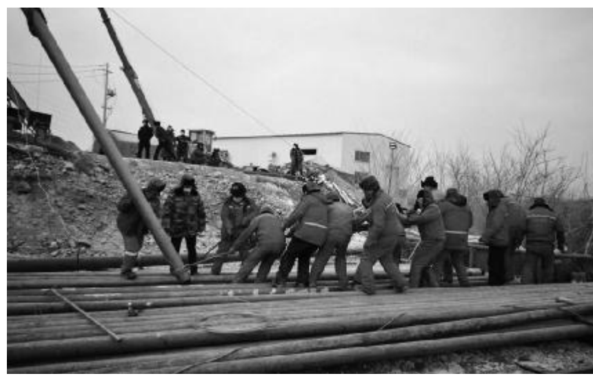
淮南项目党支部党员在施工现场开展主题党日活动。
