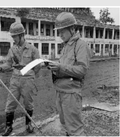
工作人员在井下进行实地核查
