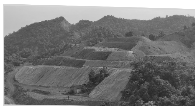
萍乡市湘东区废弃矿山生态修复中
