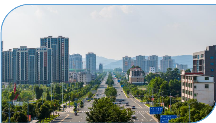
建成后的信丰县迎宾大道综合改造工程
