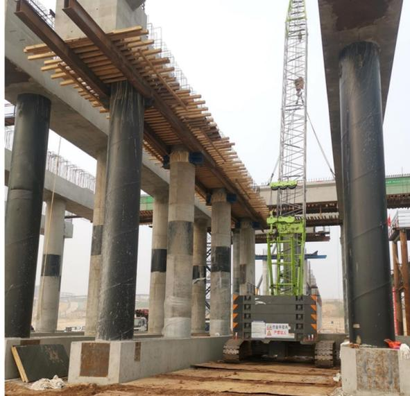
本报讯 随着一声清脆的响声响起，一片纵梁准确地落在星子港沙山码头28#-29#排架横梁上，这是江西省地质局第五地质大队在该工程项目完成的第一片预制纵梁安装，标志着沙山码头工程进入了施工新阶段。
