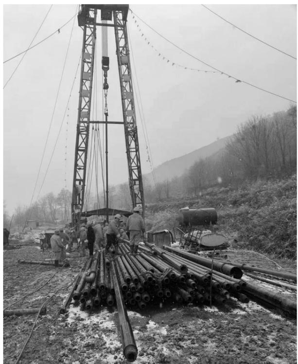
近日，陕西省一八六煤田地质有限公司综合勘探工程处2005钻机顺利完成崔木煤矿22311-6抽排孔下泵抽水作业。该孔孔深645米，主孔孔径430毫米，于2022年6月完成钻孔施工。该孔前期主要排水、后期抽水，用于崔木煤矿水害防治，是崔木煤矿井下安全生产的重要保障。该孔后续将持续抽水，以降低崔木煤矿22313工作面生产采掘中的水害风险。时超 摄影报道
