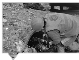
目中,技术人员身穿反光背心,头戴安全帽,将一辆CCTV管道检测机器人小车深入井下,小车在地下管网内通过红外线探测将相关信息数据和画面实时传送到指挥平台,以此检测管网的堵塞、漏滴等隐患,规范的操作,精准、翔
