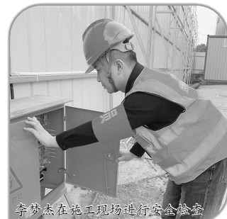
李梦杰在施工现场进行安全检查
