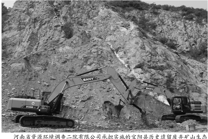
河南省资源环境调查二院有限公司承担的宜阳县历史遗留废弃矿山生态修复工程现场。该项目是河南秦岭东段洛河流域山水林田湖草沙一体化保护和修复工程子项目，中标金额6903万元，涉及治理图斑33处，分布在宜阳县11个乡镇和1个街道办事处，治理面积1916亩。资源二院公司共投入15支施工队伍、200余台各类工程机械，通过危岩清除、地表挖填方整形、边坡修整、场地平整、挂网喷播、覆土复土、绿化、截排水等进行矿山生态修复。王伟灿 摄影报道
