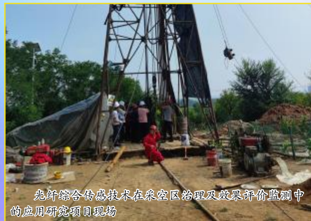
左权西矿区中深部煤层气水平井快速完井关键技术 研发及应用项目现场
