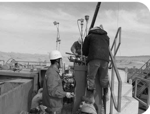
青海省茫崖市碱石山区钾盐井录井工作
