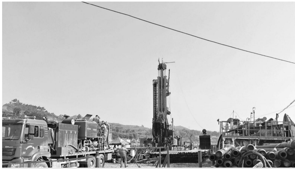
近日,山东省煤田地质局三队山西晋城煤层气项目TS102-H2水平井顺利交井,标志着该队在水平定向钻井领域实现零的突破。该井于5月开钻,钻探进尺1969米,着陆点978米,水平段进尺991米,水平段目的煤层钻遇率100%。经过近20天的奋战,施工井队顺利完成成井、下管、固井、试压等一系列施工工序,并通过验收,在水平井的钻进效率、定向技术、泥浆技术、水平井下套管技术等多个方面填补了该队在该领域的空白。
