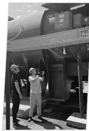
袁大滩机电设备全生命周期管理系统设备安装现场
