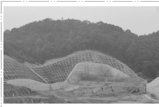
总局江苏局长江环境公司银城·临安颐和山庄项目C区山体支护治理工程进展顺利，已完成总工程量的75%，计划年底前完成主体施工任务。项目位于杭州市临安区科技大道北C区山体高陡边坡，边坡总长度约1033米，高度约3-25米，均为挖方边坡，存在崩塌、滑坡隐患，须对斜坡采取支护措施。项目采取1.5米直径抗滑桩、桩侧板墙、锚杆锚索、格构梁、跌水沟、林道、植生袋挂网绿化、防护围栏等工艺措施，消除山体崩塌、滑坡隐患，保障后期住户安全，改善当地生态环境。水起 冯文霞 摄影报道
