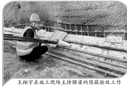
王翔宇在施工现场主持腰梁的隐蔽验收工作
