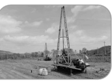
环境地质与灾害防治工程院天水市秦州区兰花小镇建设项目岩土工程勘察施工现场
