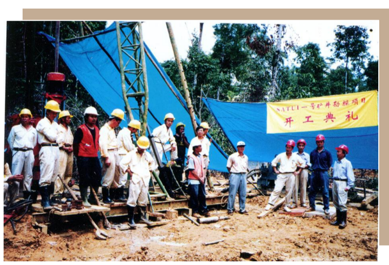
印度尼西亚项目施工现场
