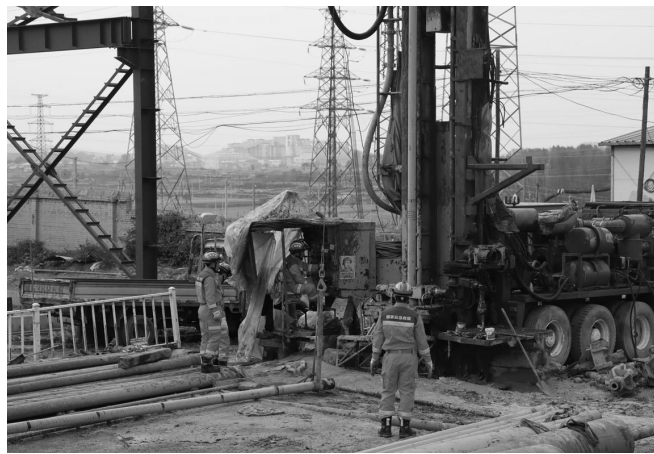
近日，国家矿山应急救援山西特勤114中队依托潞安集团古城煤矿投料井项目，开展了大口径救援通道构建实战演练，首次使用车载钻机圆满完成构建大口径救援通道的目标，首次使用50吨吊车与吊卡套管轮番进行起吊、焊接、水平放置等特殊处理，有效解决了大口径钻孔施工中面临的破岩速度慢、孔壁不稳定、长距离排渣难、透巷精度低等技术难题，试验了高精度随钻测量仪器与安全透巷钻井工艺，并针对施工大口径钻孔形成了一套标准化操作流程，进一步提升了中队矿山应急救援能力和水平，为今后矿山事故救援打下了坚实的技术基础。
