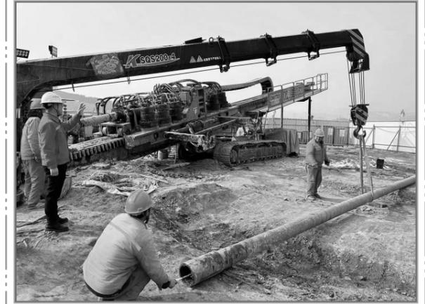
春节期间,安徽两淮控股集团有限公司两淮建设有限责任公司管道分公司山东烟台南山山体定向钻工程项目部人员坚守岗位连续施工,开足马力推进项目进度。作为连接烟台港西港区至龙口裕龙岛原油管道的关键一环,该项目的顺利实施对优化区域能源结构,提高输电效率,促进地方石油化工产业发展具有战略意义。项目部制定了周密详尽的工作计划和施工保障方案,科学合理安排施工工序,预先做好现场材料及各类高精尖钻具的一次性储备,确保能在突发状况下迅速响应,维持项目高效稳定连续施工。春节期间,加强物资保障,高度重视现场安全管理,严格遵循操作规程,保障了春节期间项目安全生产工作平稳有序。截至发稿时,项目总体施工进度完成85%以上,正在为38吋钻头扩孔做施工准备。
