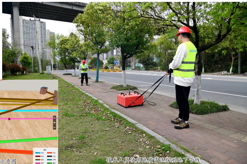
作业人员使用地质雷达探测地下管线
