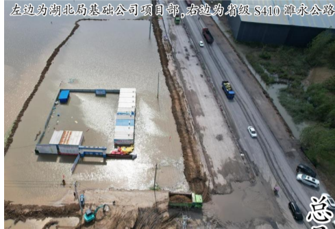
左图为湖北局基础公司项目部，右图为省级S410滁永公路
