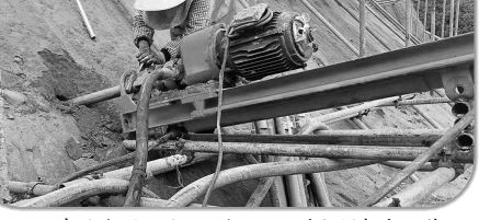
在信宜项目实施现场，工人进行锚杆成孔作业
