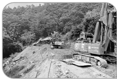
高州项目抢修施工便道
