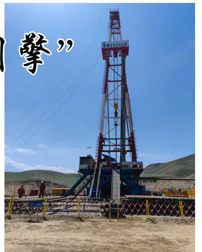
新疆亚新煤层气项目
